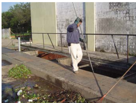
Figura 5. Limpeza do poço da CB 12
