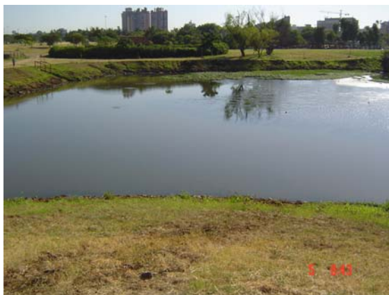
Figura 3. Bacia de detenção. Foto na direção sudeste. Ao fundo a entrada do canal da avenida José de Alencar
